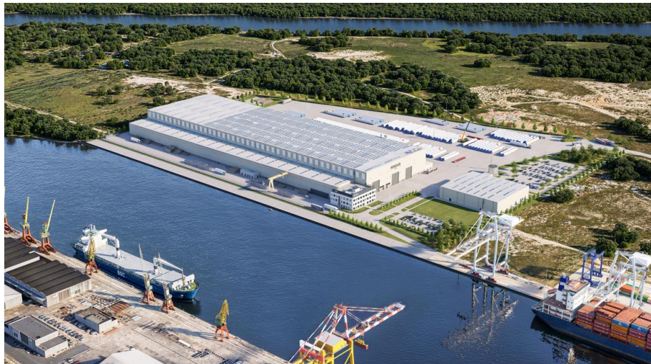
PORR postaví novou továrnu během 18 měsíců © Industria Project
