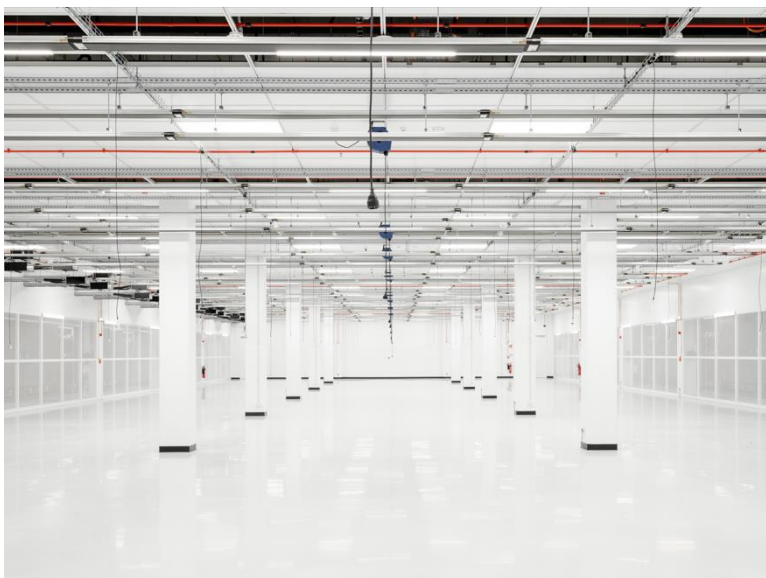
Výstavba datových center je spojena se zvláštními požadavky © PORR
