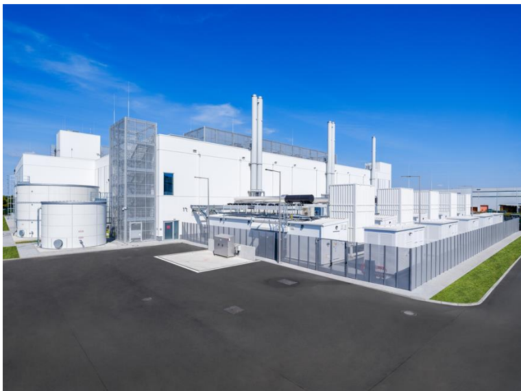
Společnost PORR získala zkušenosti s výstavbou datových center v Polsku a Německu © PORR
