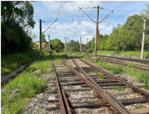
PORR prování na na zakázku Rumänischen Nationalen Eisenbahngesellschaft sanaci 32,6 km železniční tratě © PORR
