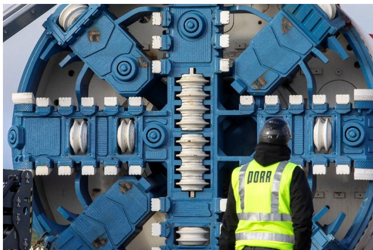
Proražení tunelu ElbX pod Labem bylo dokončeno na straně Dolního Saska. © PORR
