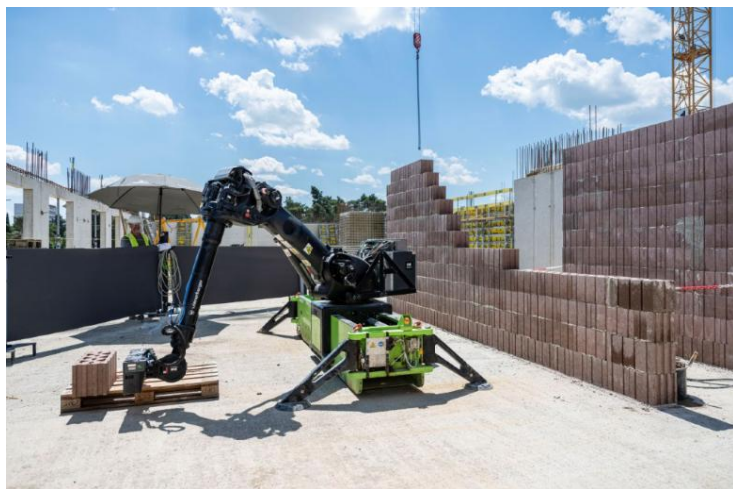
Walter dokáže zvedat tvárnice o hmotnosti až 52 kg © PORR/Jan Hrdý
