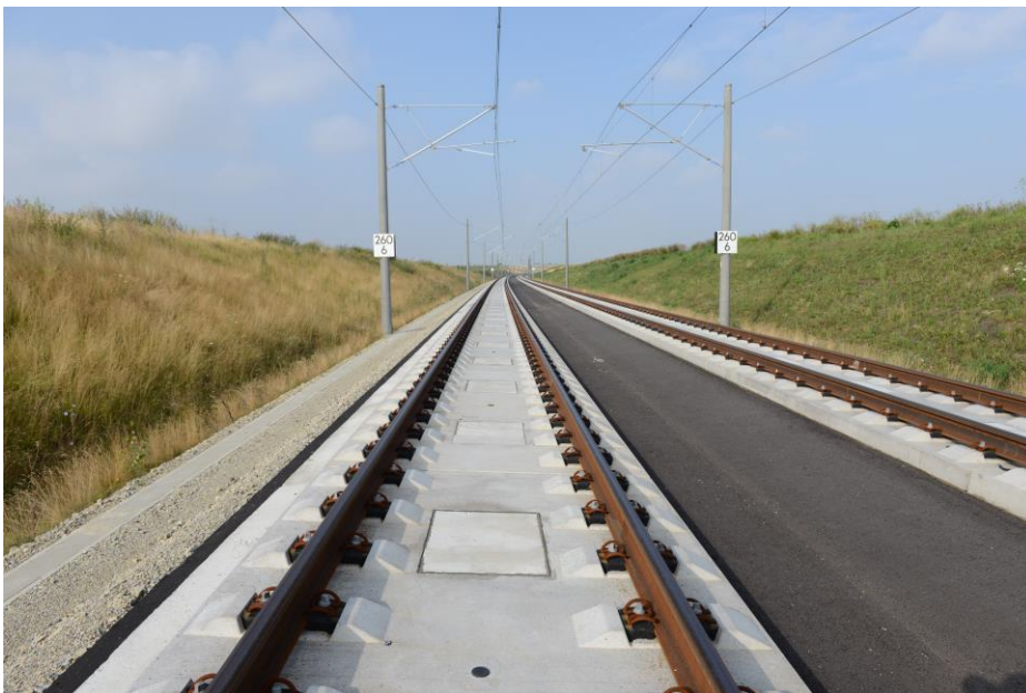
Popis obrázku: technologie Slab Track Austria se úspěšně používá na vysokorychlostních tratích, při výstavbě metra i rekonstrukcích tratí v Evropě i Asii (Copyright: © PORR)
